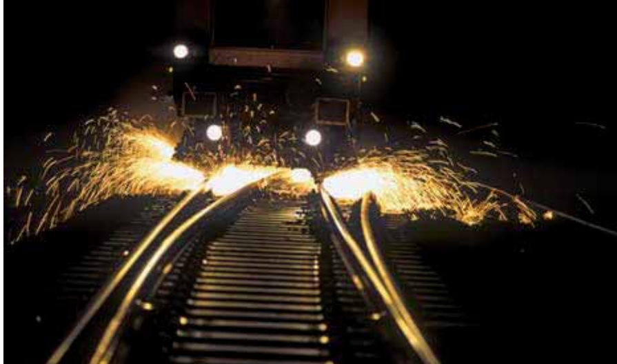
Besonders überwacht Gleis: der Schienenschleifzug im Einsatz
