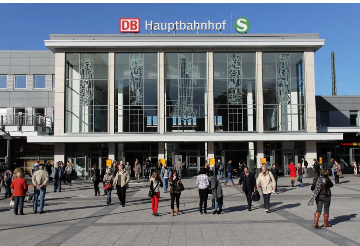
Die Empfangshalle des Dortmunder Hauptbahnhofs wurde bereits saniert. Ab 2018 werden auch die Bahnsteige und die Personenunterführung modernisiert.
